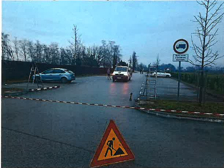
Saniranje rampe na Novom groblju.
