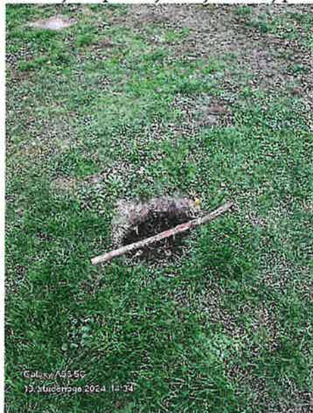
Sanacija rupe na javnoj zelenoj površini u Kolodvorskoj ulici.
